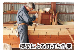
棟梁による釘打ち作業
